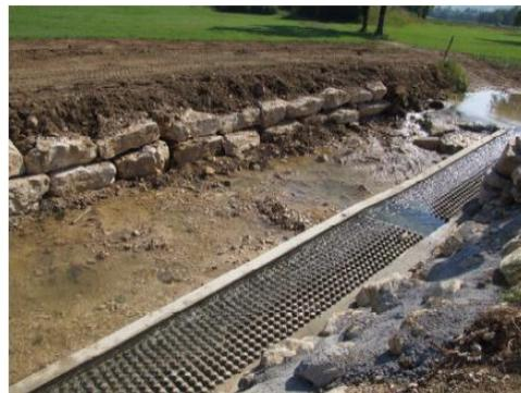
**Fig. 31. Exemple de rampe evergreen avec bassin de repos (source : étude sur la Lamproie de planer de 2009)**
