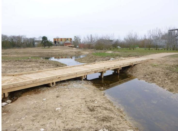
Exemple de passerelle submersible avec chasse-roue. Moe
